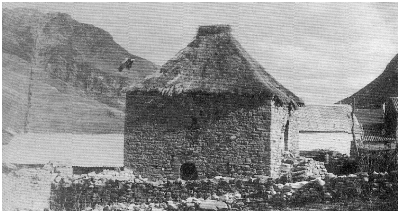
Torre medieval de Torrestío (Babia-León), antes de su reparación
